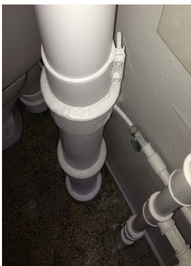
Reparation på faldstamme
